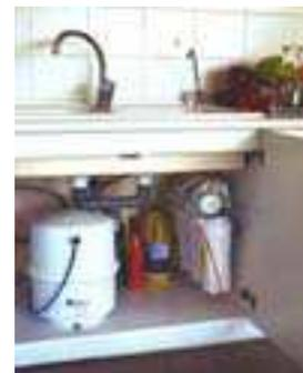
Se instalan debajo de la fregadera, con un pequeño depósito de acumulación presurizado que envía el agua a un grifo adicional instalado al lado del habitual. Existen también grifos de tres vías, que se instalan en vez del convencional de dos vías (fría-caliente) llevando en este caso un monomando adicional que acciona la salida del agua osmotizada para beber, cocinar o lavar frutas, verduras, etc.).
